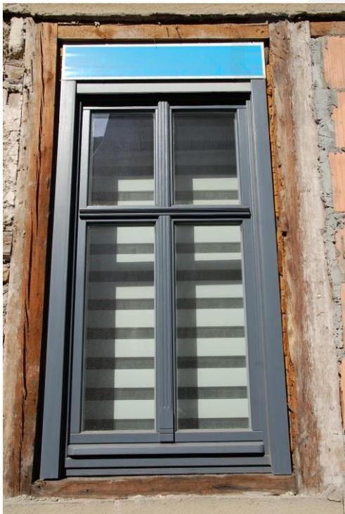
Konstruktives Beispiel für einen geschickt versteckten Röllladen. Im Endausbau überdeckt die Holzbekleidung den Kasten und die Fugen.
